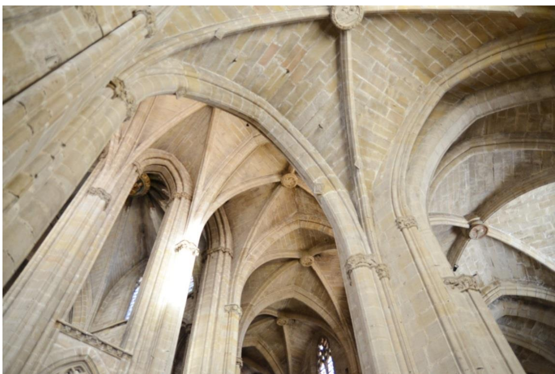
Figura 2.11. Pilar entre las capillas y el deambulatorio. Arranque de arcos y nervios a diferente altura (Costa, 16/02/2015).
